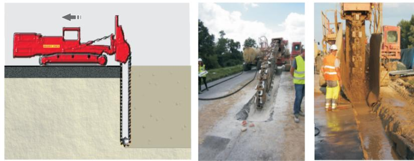
Exemple d'étanchéification par mélange en place des matériaux de la levée avec du ciment
