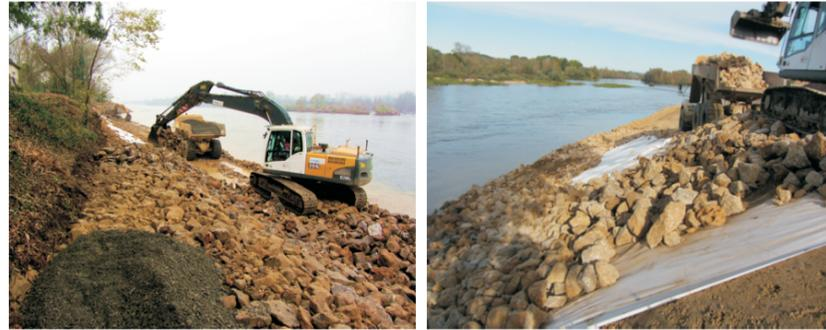
Exemple de renforcement des levées par enrochement
